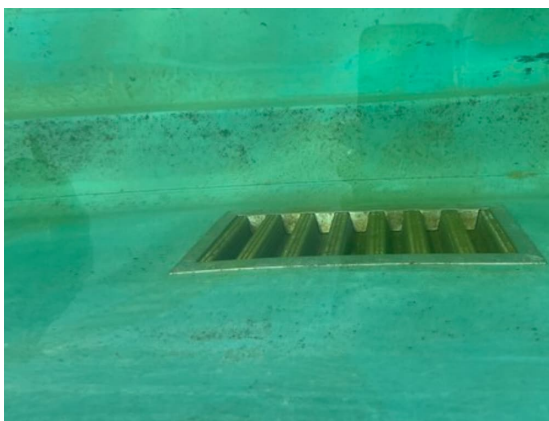
Bild 34: Ansaugstelle Becken
