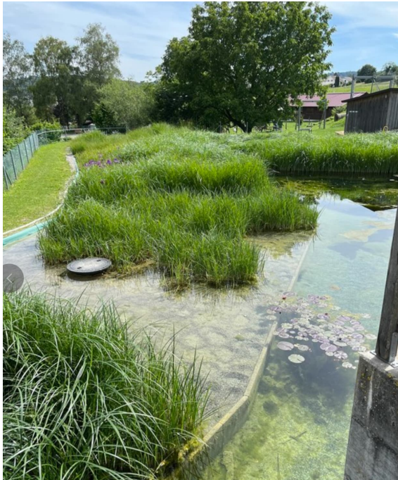
Bild 29: bestehender Pflanzenfilter, wird im südlichen Teil beibehalten
