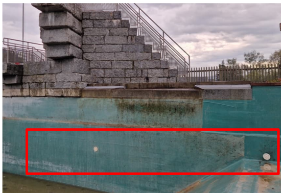
Bild 18: Eine Lage Düsen Sprungturm
