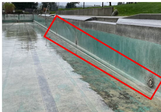
Bild 19: Eine Lage Düsen Schwimmer
